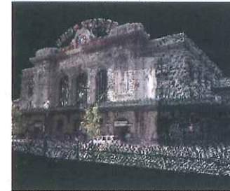
Real Works – Estación en Color Real
